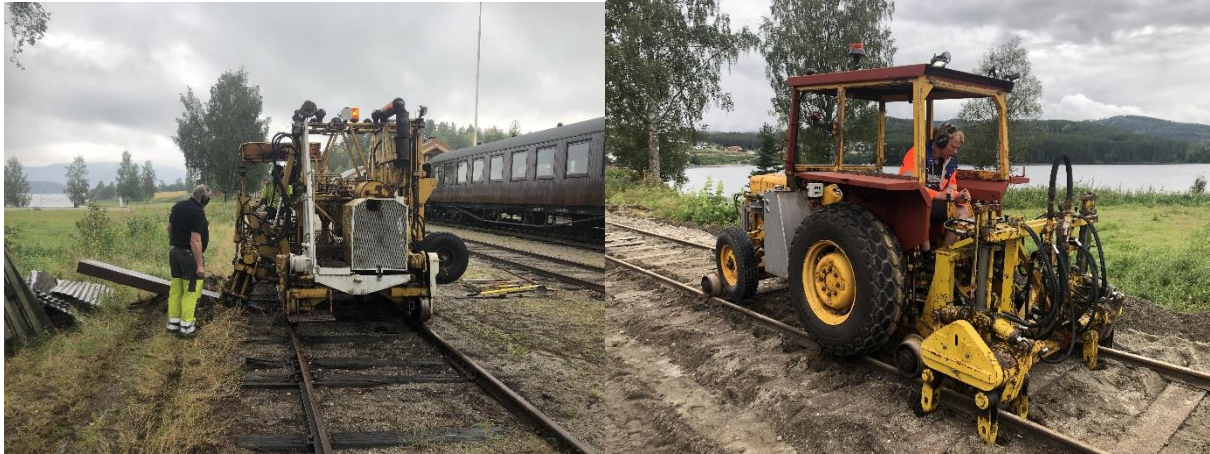
Utskifting av sviller med stikkbyttmaskin i spor 3 og pakking av sporet med pakketraktor. Foto Henrik B. Backer
