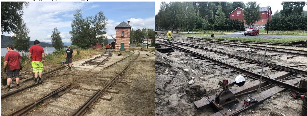
Demontering av sporveksel og det ferdige resultatet til høyre. Foto Henrik B. Backer
