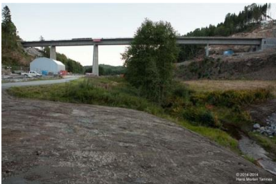
Ønna bro i full lengde, sett mot Langangen.
