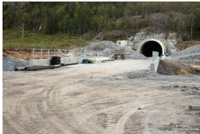
Herregårdsbekken bro og portalen til Eidanger tunnel, 36 og 2 080 meter lange.
