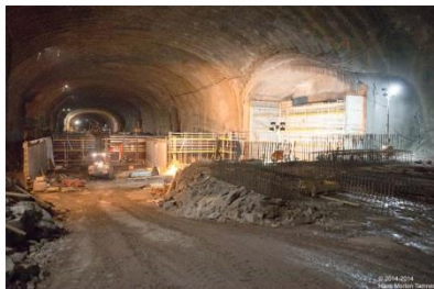
Det er store dimensjoner. Arbeidet med å støpe rom under sporene har startet.
