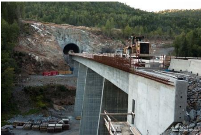
Ønna bro, 228 meter lang, 30 meter over dalbunnen.
