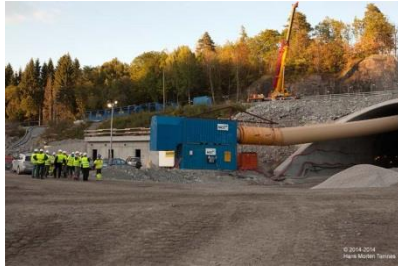
Samling ved Herregårdsbekken. Til høyre skimtes portalen til Storberget tunnel.
