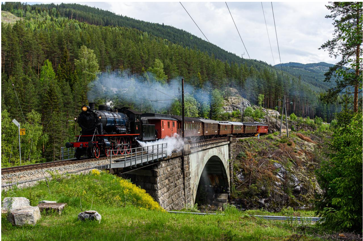
Toget til Bergen passerer Svenkerud bru. Foto: CF Salicath
