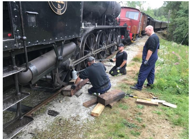
Arbeid etter avsporingen 5. august. Foto: Lars Fredrik Andersen
