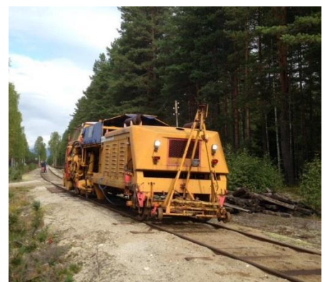
Pakkemaskin i arbeid med utbedring av sporet. Foto: Pål Stian Wahlquist
