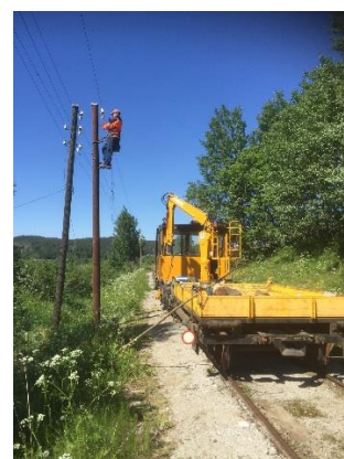
Dagfinn Lunner flytter over telegraf- og telefonkursene fra gammel til ny stolpe mellom Tarmen og Hære Foto: Henrik B. Backer
