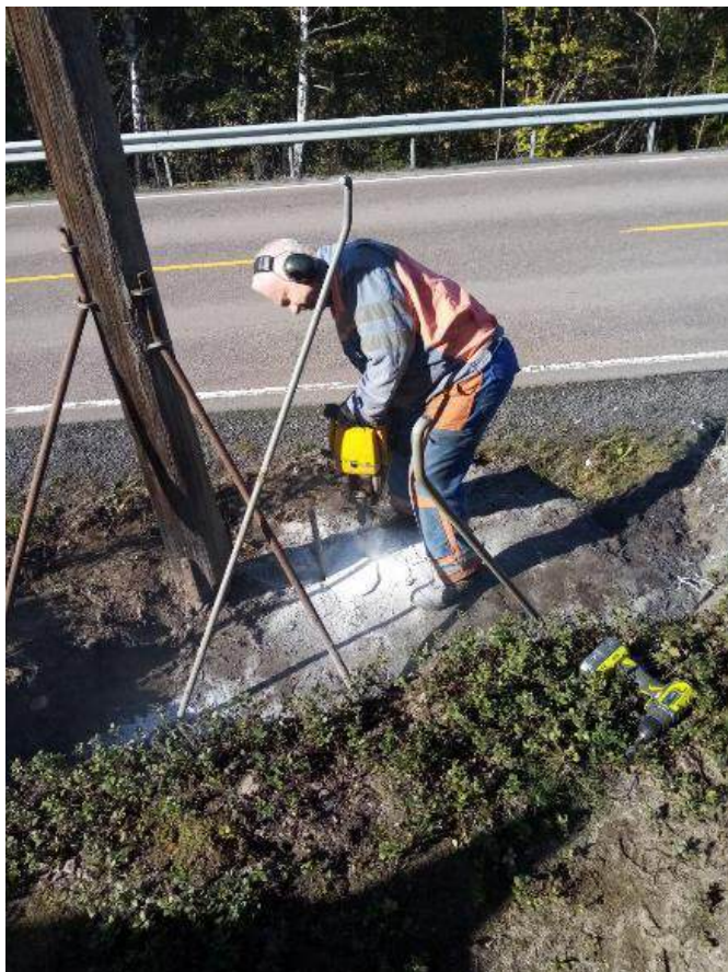
Telegrafmester Dagfinn Lunner borer hull til nytt fotfeste for telegrafstolpe ved km 108,3. Foto: Trond Rørvik
