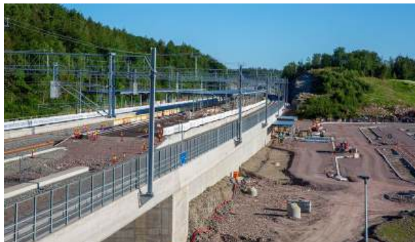
... før bussturen langs den nye strekningen. Ved det som blir Horten stasjon kom vi ut i friluft og kunne vi se det nye anlegget.
