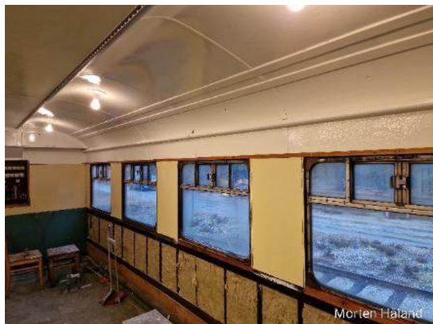
Nye tak- og veggplater er på plass, og malt. Foto: Morten Håland
