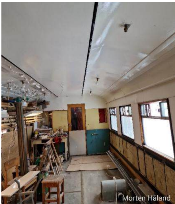
Nye takplater er på plass, og malt. Foto: Morten Håland
