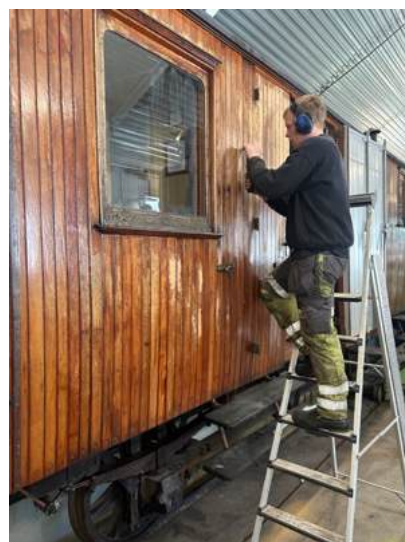
Kristian Nøkleby skrapper teakkledning på CF 3552.
