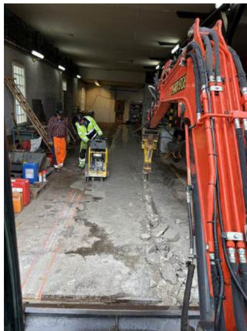
Bygging av spor i lokstallen Mysen. Foto: Per Martin Kjeldaas
