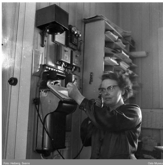
«Stasjonsmester» Margot Korsbøen på Kløttefoss stasjon i 1958.
