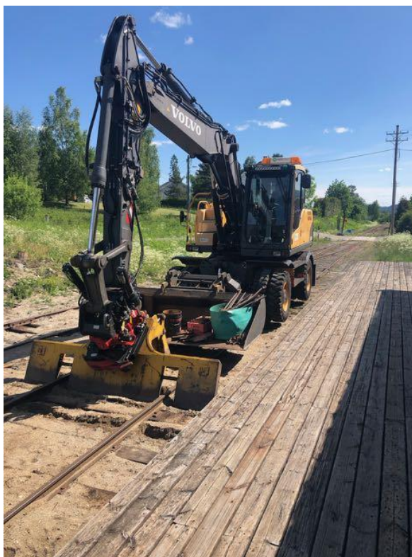
Svillerbyttmaskinen til NRC tar en pause på Snarum stasjon.
