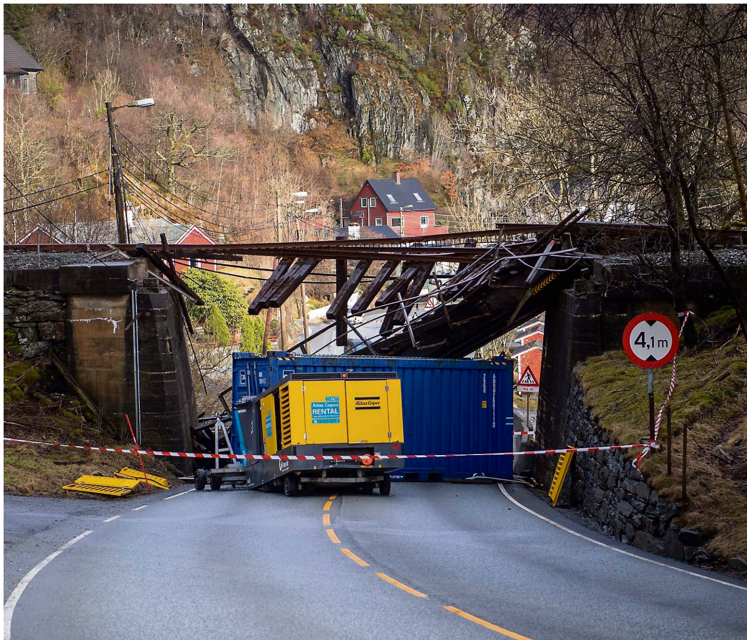
BROEN OVER FV 587: Jernbanebroen over Hardangerveien ble bokstavelig talt kjørt ned sist fredag. Nå haster det å få den reparert igjen slik at veteranjernbanen igjen kan rulle for fullt.
